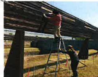
小口径バックフル整備
